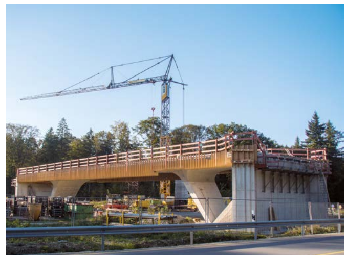
Bild 1 Brücke BW03 über B20 nach Fertigstellung, noch ohne seitliche Rampen und Dämme Overcrossing bridge BW03 over highway B20 after finishing, still with formwork
