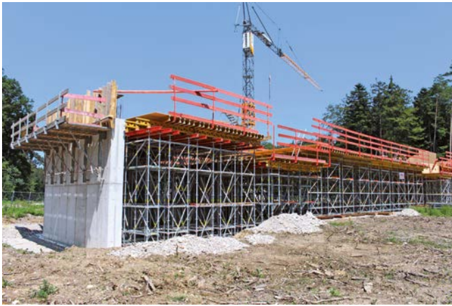
Bild 10 Überbauschalung auf fertiggestelltem, bodengestütztem Traggerüst Superstructure formwork on finished, fully supported falsework
