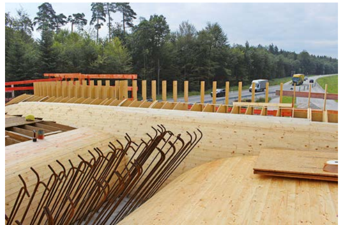
Bild 12 Blick in die Überbauschalung mit Anschlussbewehrung des vorab hergestellten Schrägstiels Superstructure formwork with connecting reinforcement of first built slanting shaft
