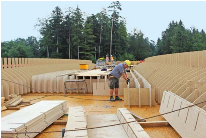
Bild 11 Schalarbeiten an der Überbauschalung mittels Stecksystem und anschließender Beplankung Formwork on superstructure with a plug-in-plug-system and future covering
