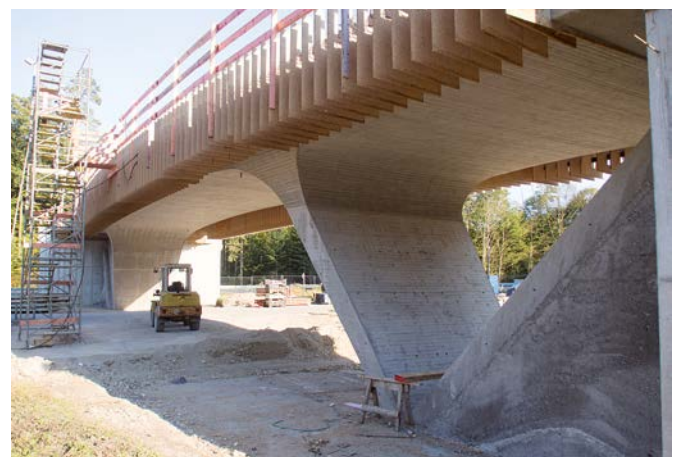
Bild 14 Untersicht des fertiggestellten Bauwerks mit Kappenschalung Finished bridge with late formwork
